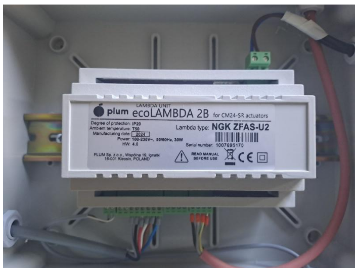
Obrázky 7. Montáž a zapojení modulu LAMBDA do nové rozvodnice
